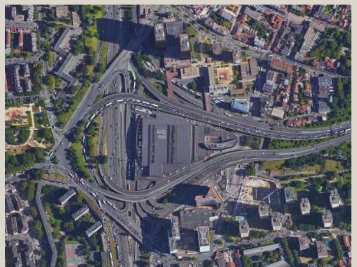
Le méandre routier structure les flux routiers sur plusieurs niveaux. Source : Google Earth (2019)
