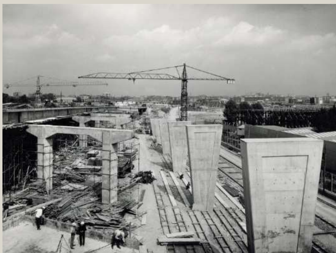
La construction du boulevard périphérique - Source : INA
