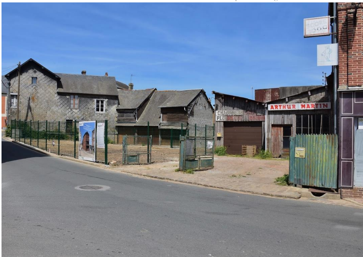
Illustration 6 – Démolition-reconstruction de parcelles insalubres, centre-ville du Sap, © Dorian Bianco, 14/05/2022.
